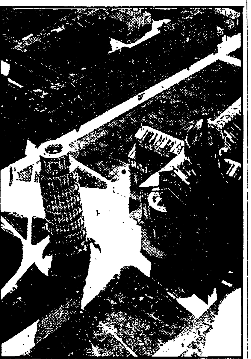
Dall'equilibrio della falda acquifera del sottosuolo di Pisa dipende la stabilità della torre. Quest'anno la falda freatica si è abbassata di nuovo
