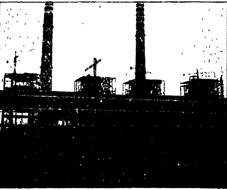
La centrale di Rossano
