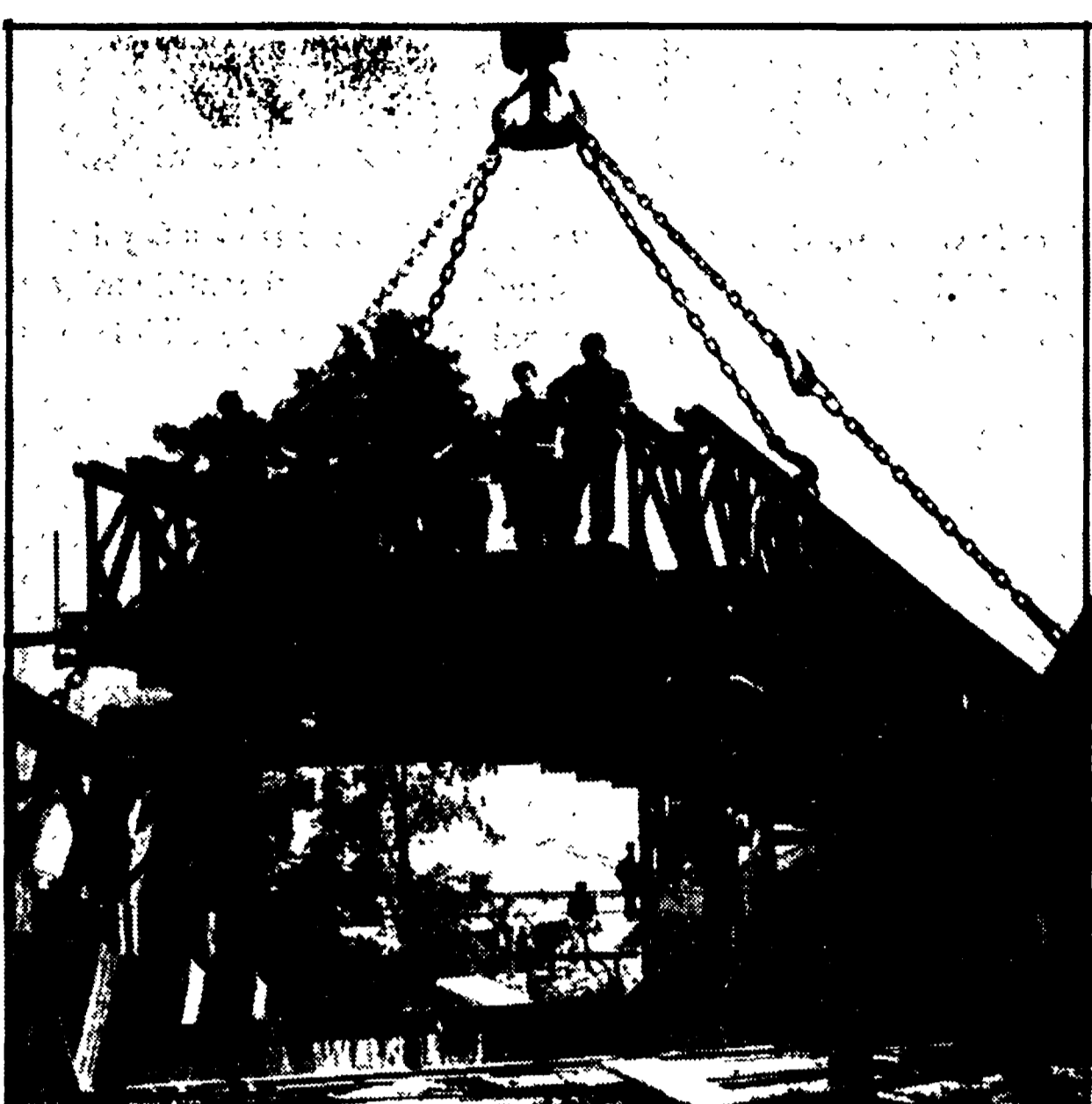
MEDA, 5. - La notte scorsa, in poche ore, 170 soldati, 8 solfaccianti e 12 ufficiali hanno costruito un ponte di ferro sullo svincolo della superstrada Milano-Meda, per consentire ad automobilisti e pedoni di non passare in uno dei tratti più inquinati dalla diossina e per evitare il completo isolamento da Meda-Centro, di una frazione, quella di Meda-Polo. Dal 25 luglio gli artiglieri e i bersaglieri del 3. Corpo d'Armata sono a Meda: hanno provveduto a delimitare con il filo spinato i quartieri evacuati. Tutti i militari indossano indumenti protettivi e vengono frequentemente sostituiti per evitare il pericolo di contaminazione. Nella foto: una fase della costruzione del ponte
