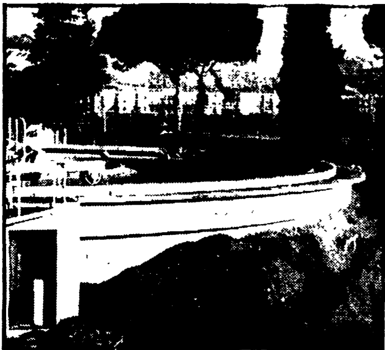
Un aspetto degli impianti dell'Anconella
