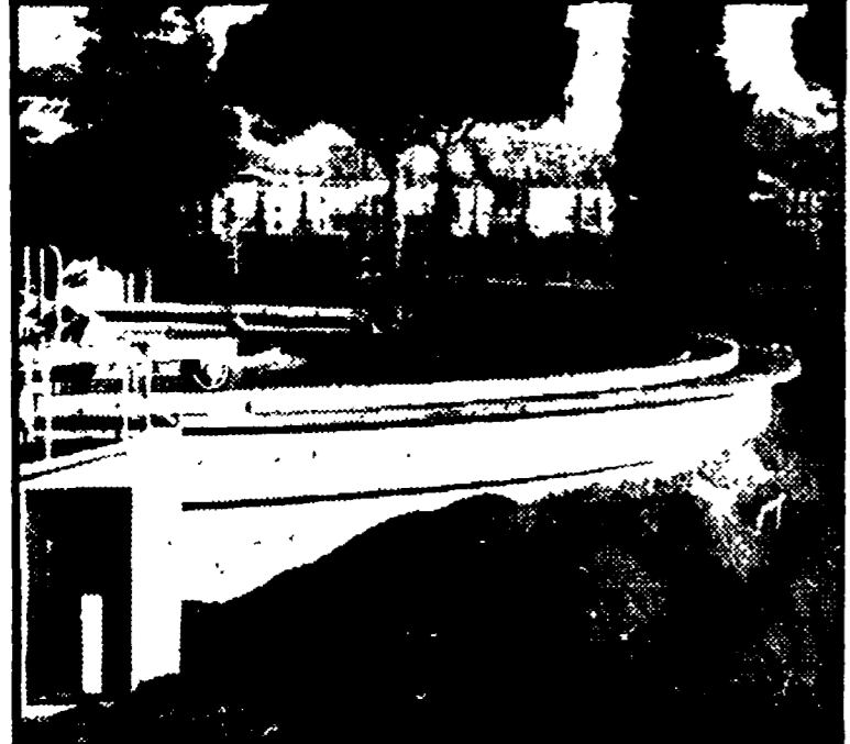
Un aspetto degli impianti dell'Anconella
