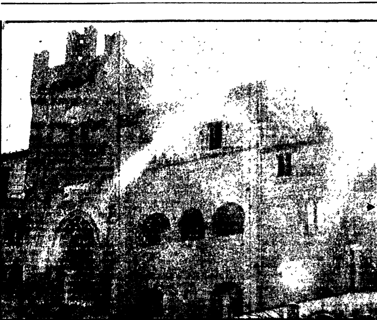
La stupenda facciata del Castello di Ponzano
