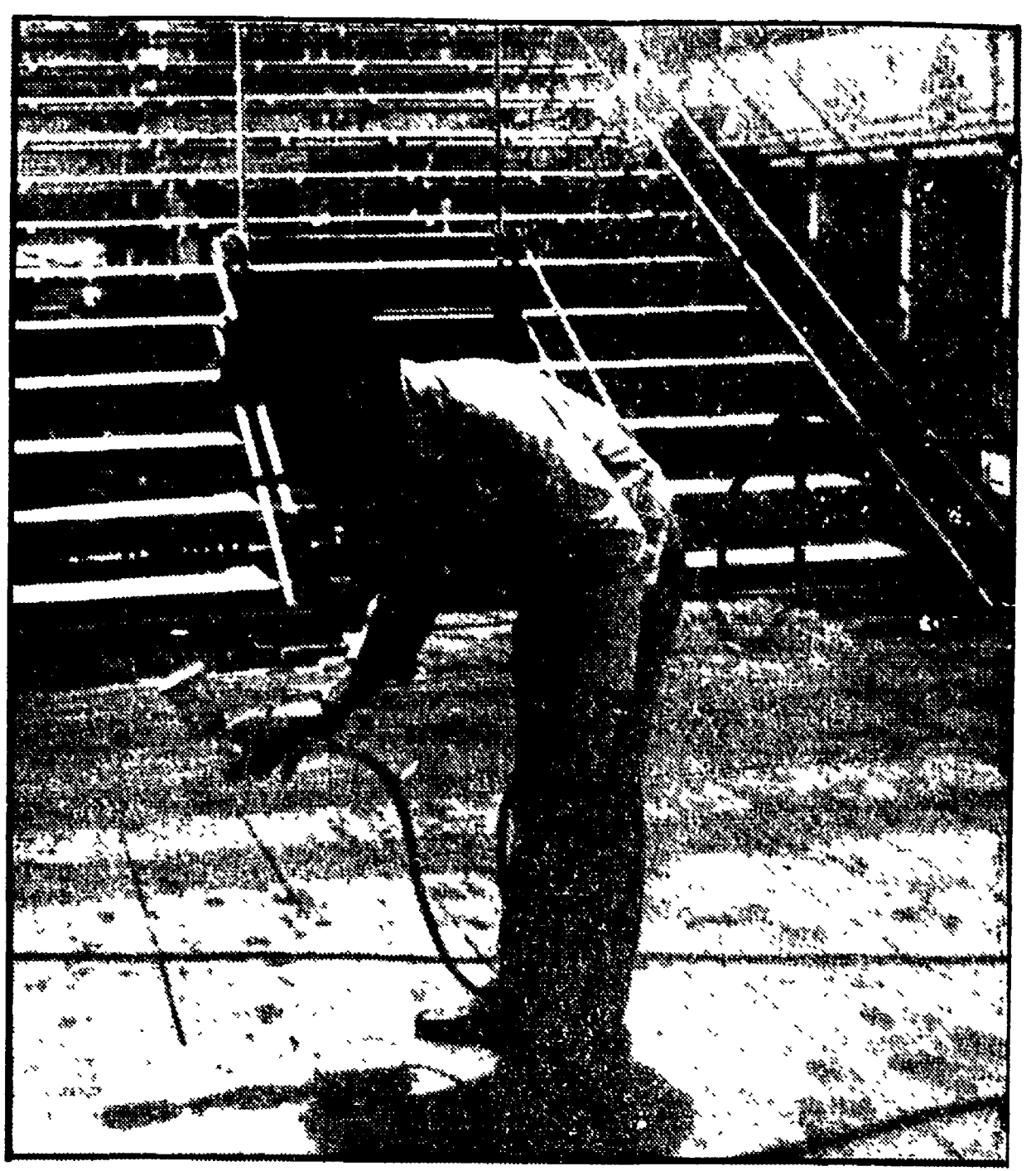
Si spruzza la speciale vernice «antincendio» che ha permesso la riapertura del teatro Goldoni
