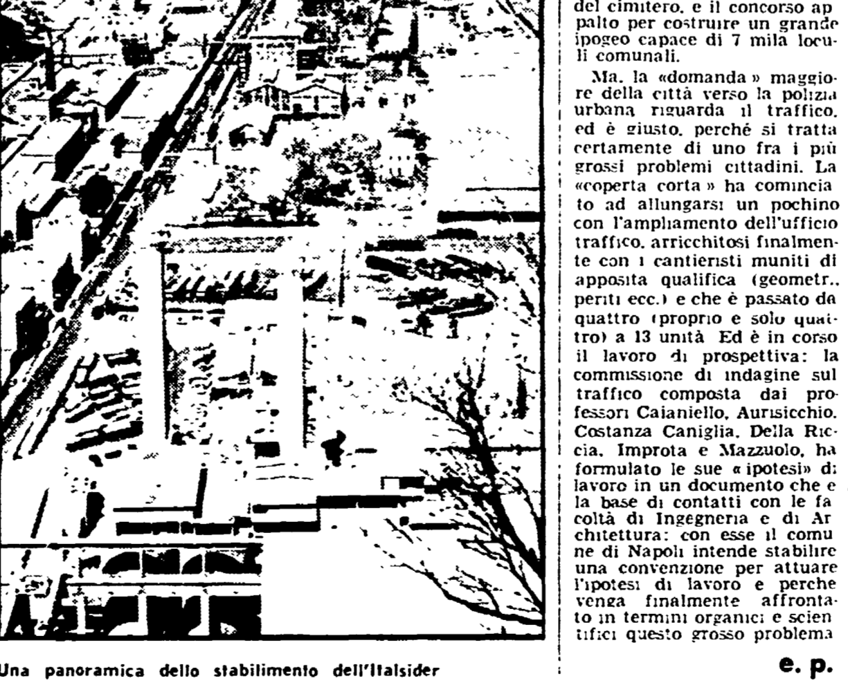
Una panoramica dello stabilimento dell'Italsider
