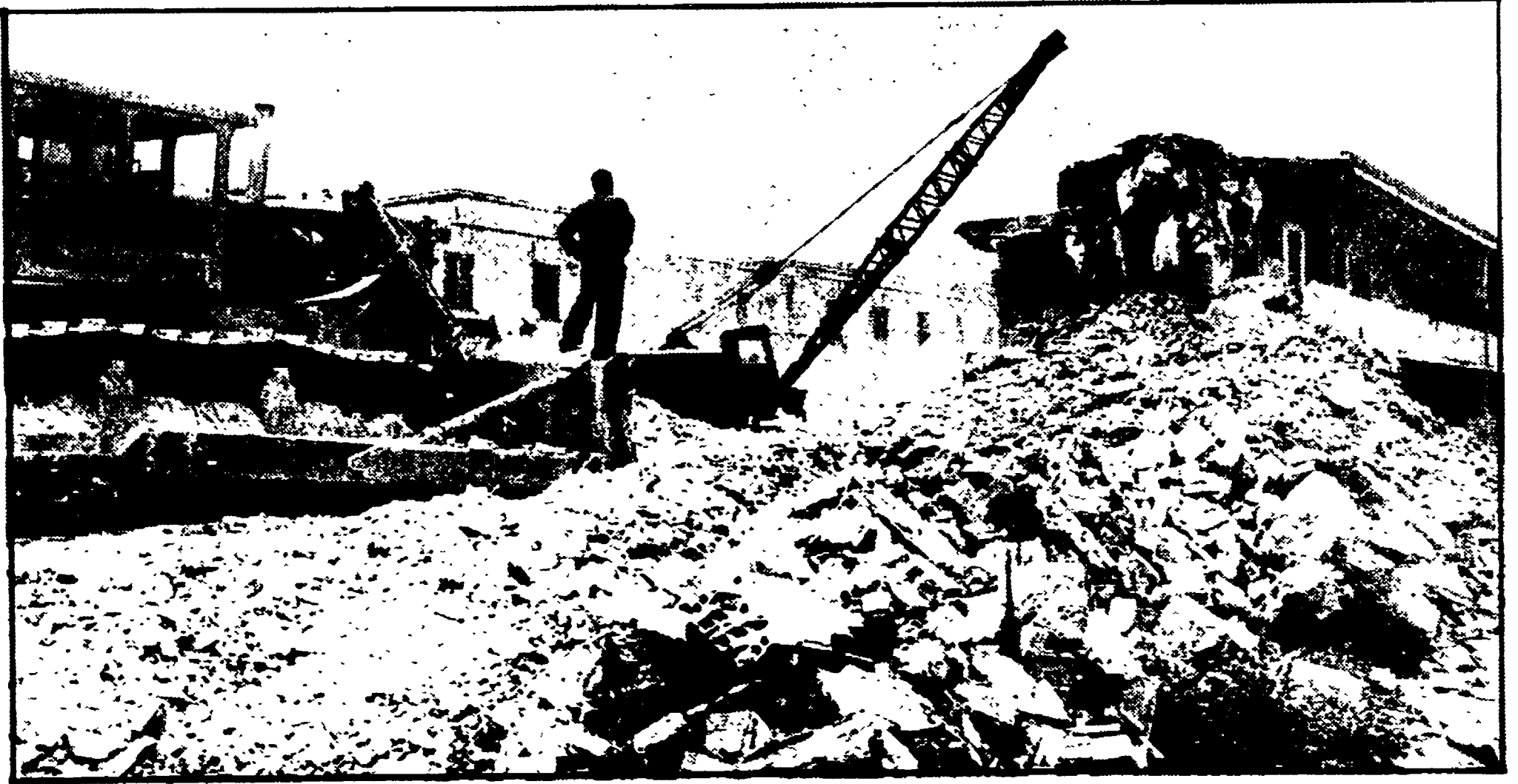
La ruspa continua ad abbattere le costruzioni fatiscenti di Tiburtino III. Al loro posto sorgerà un nuovo complesso di edifici popolari
