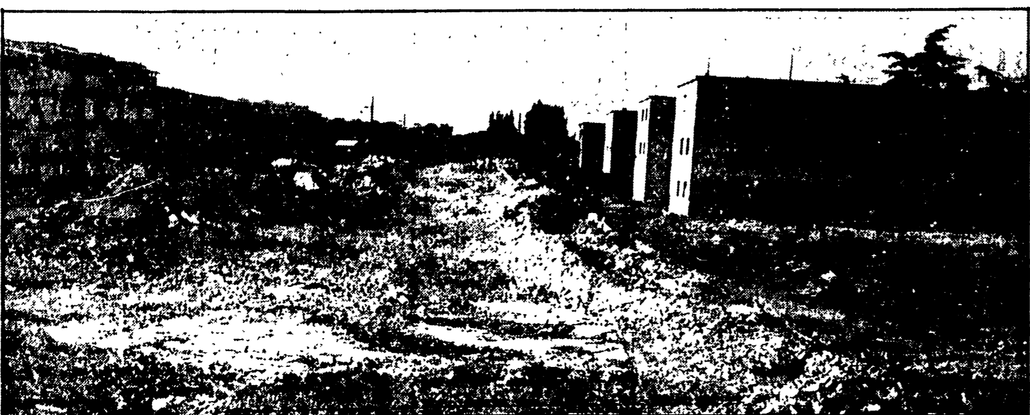
Le ruspe hanno completato ieri i lavori di demolizione di due dei vecchi lotti di Tiburtino III
