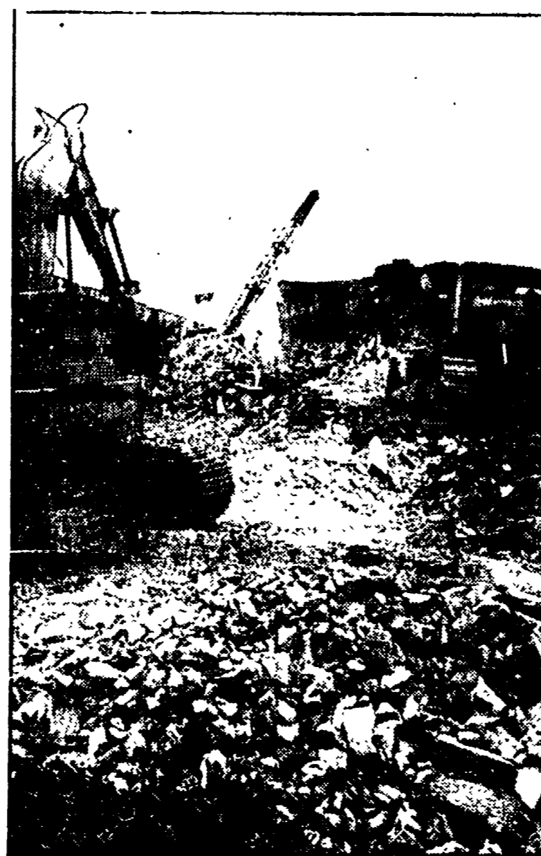
Una fase del lavoro di demolizione
