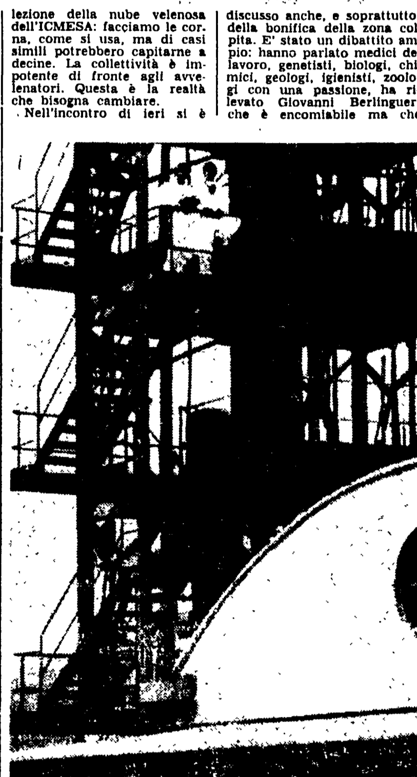
SEVESO — La torre dell'ICMESA dove è situato il reattore che provocò la fuoriuscita del gas tossico il 10 luglio scorso.
