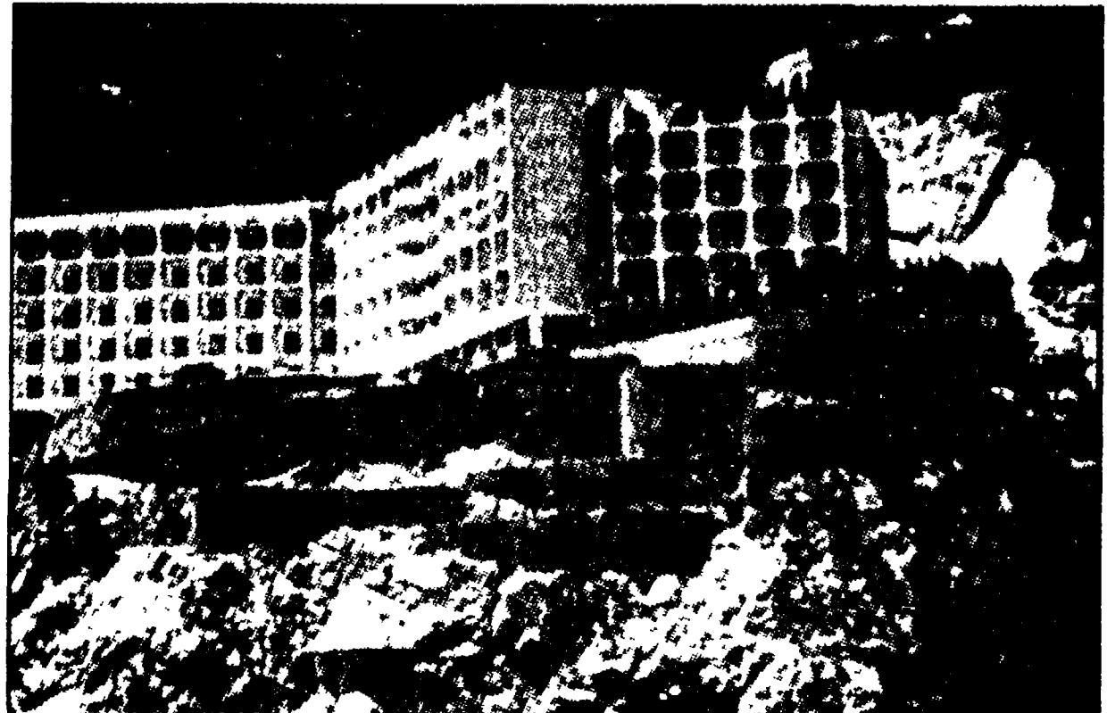
Un aspetto dell'albergo che dovrebbe essere demolito per il modo in cui è stato realizzato e che invece dal medico provinciale ha ricevuto il certificato di abitabilità
