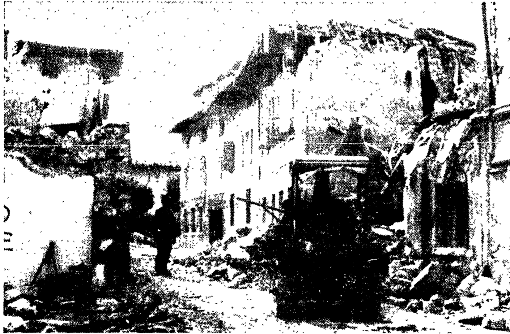
GEMONA — Una ruspa dei vigili del fuoco in azione nel centro di Gemona per rimuovere le macerie di una casa crollata in seguito alle violente scosse di sabato sera. E' stato in gran parte vanificato il lavoro compiuto in quattro mesi per riparare la casa lesionata.
