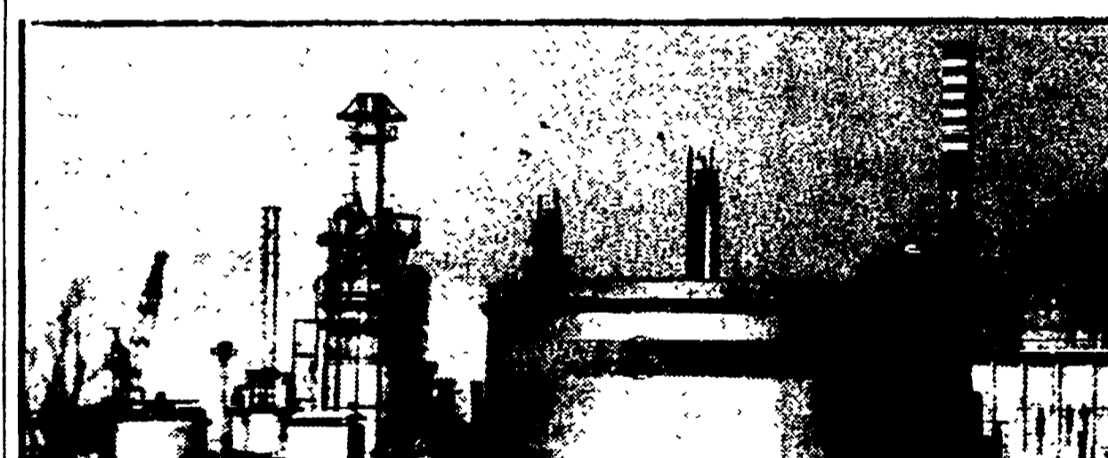
Gli impianti della STANIC di Bari
