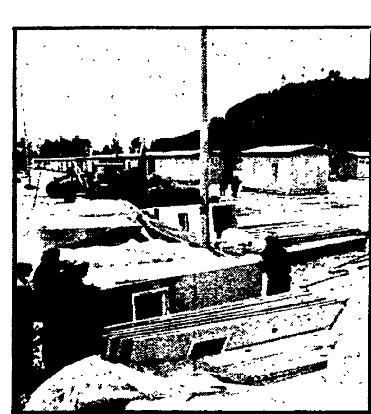
OSOPPO - Si costruisce un villaggio con i prefabbricati inviati dalla Regione Lazio
