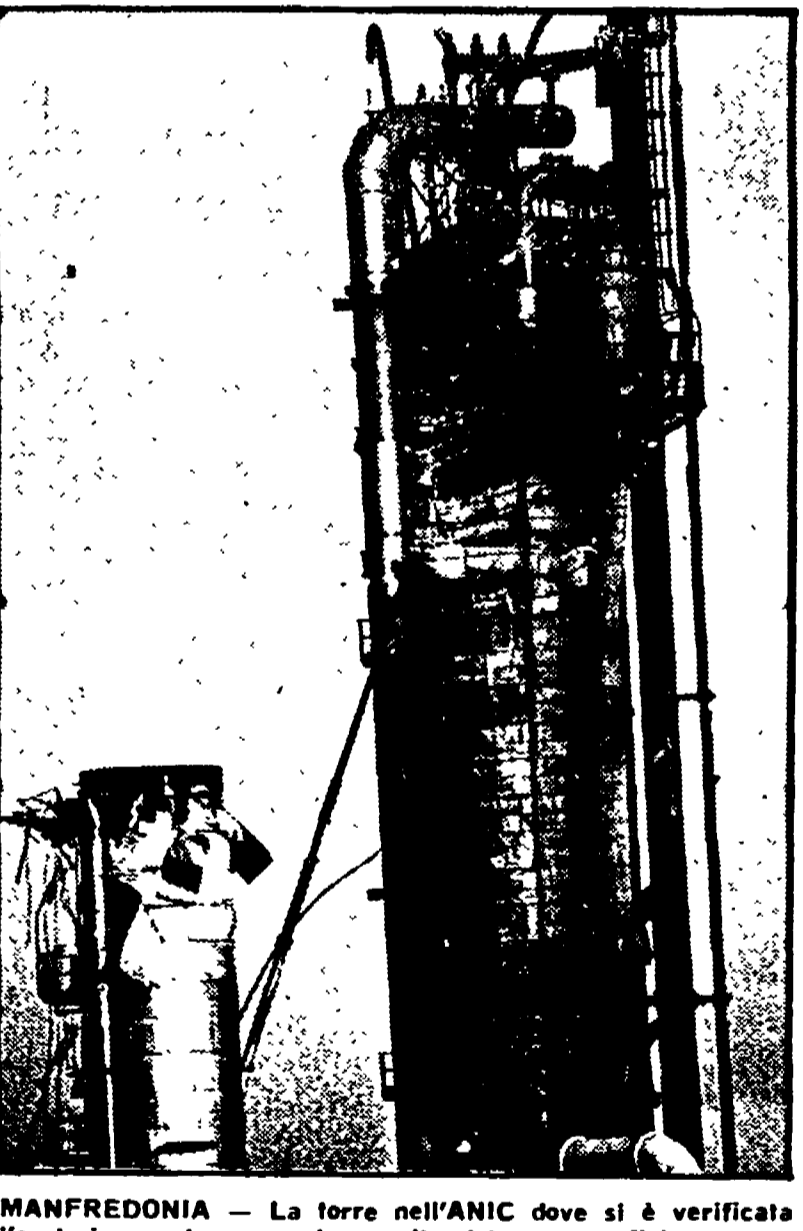
MANFREDONIA - La torre nell'ANIC dove si è verificata l'esplosione e la successiva uscita dei gas velenosi
