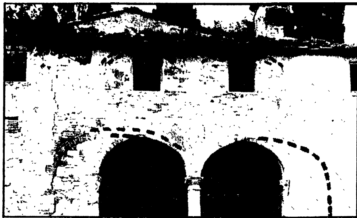
Casa colonica con architettura a seso ribassato. Nonostante le evidenti ristrutturazioni (le linee indicate dal doppio tratteggio rosso) l'immobile precedente dell'arco costituisce un raro esemplare tipologico della zona del Mugello
