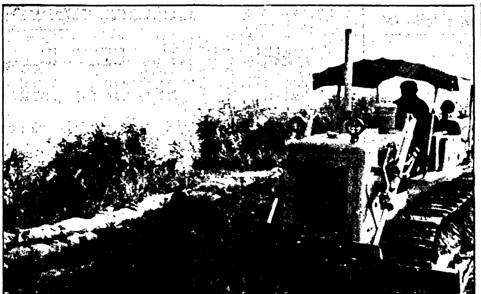
GORO (Ferrara) — Si lavora a rinforzare gli argini del Po
