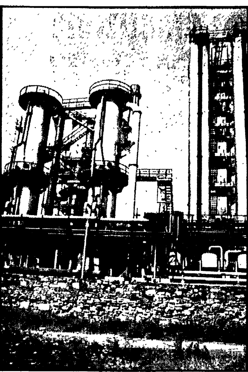
Una veduta degli impianti dell'Italsider di Piombino
