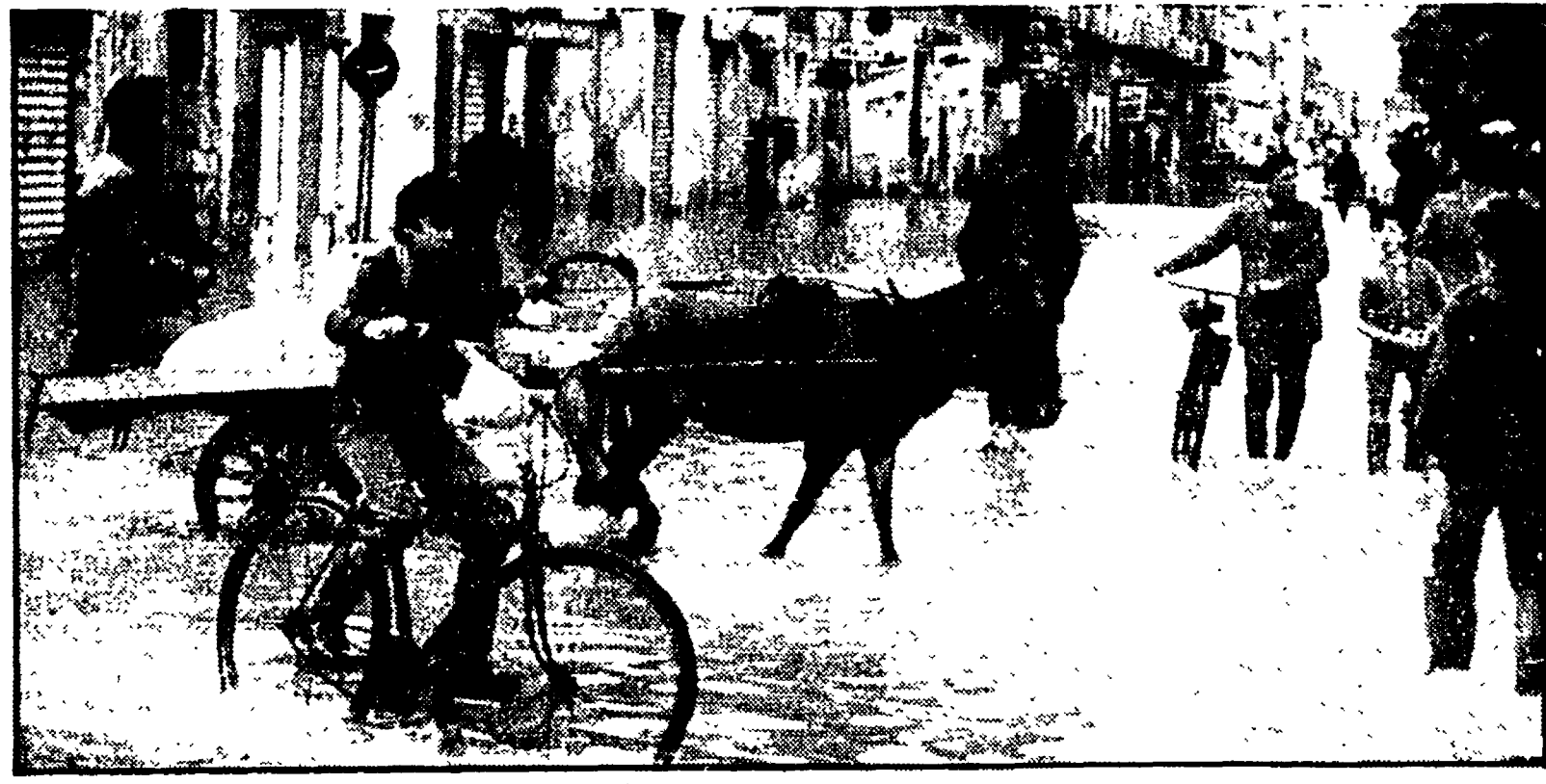
TRAPANI - Le vie, i negozi e le abitazioni nuovamente allagate dopo le abbondanti piogge
