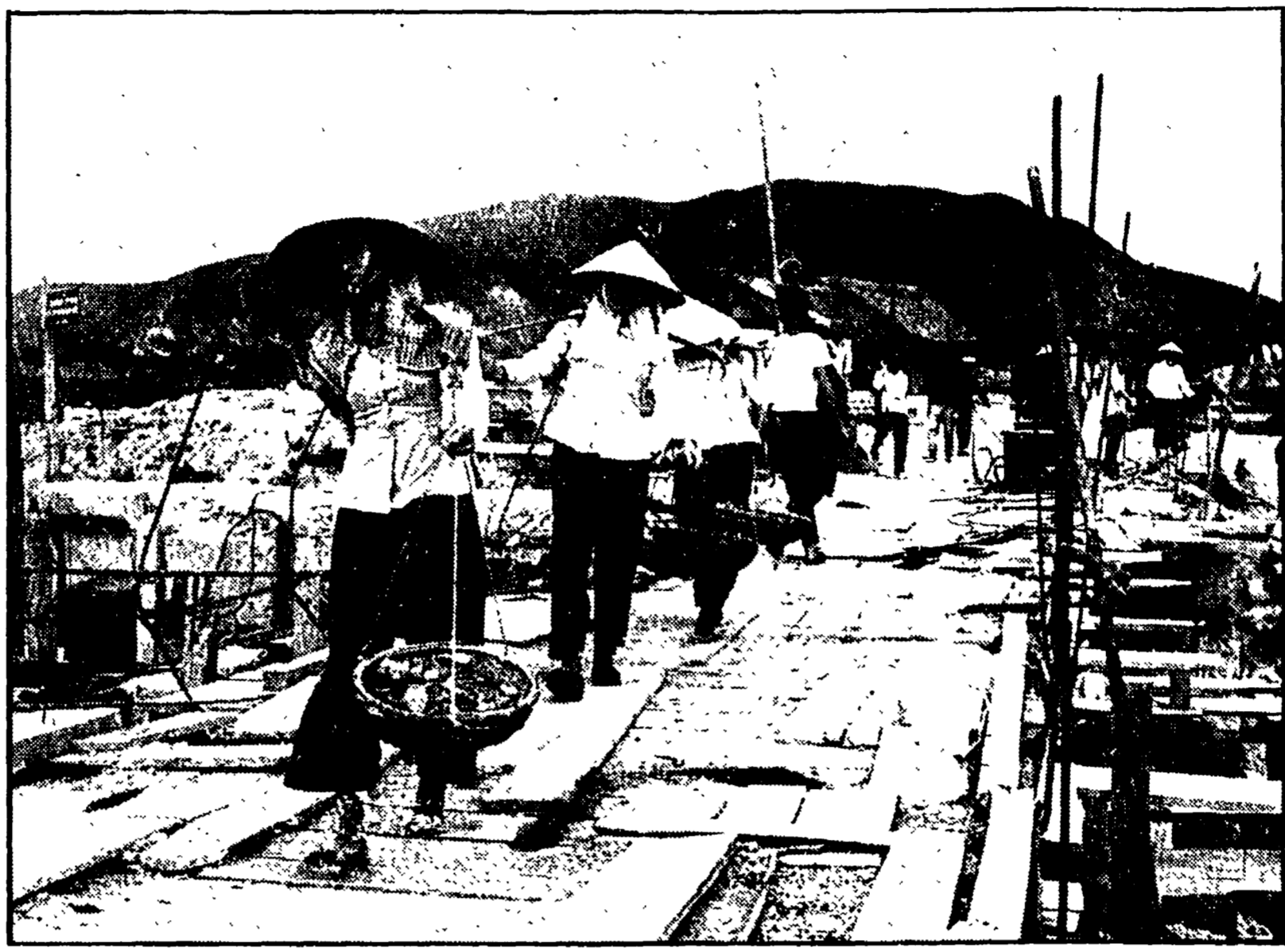
Donne vietnamite al lavoro nella ricostruzione di Song Kha Dam
