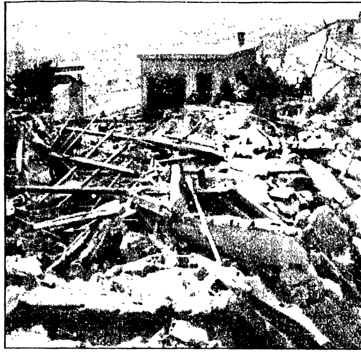
VALANGA DI TERRA A S. MARINO Una frana venuta giù dal monte Tifano a San Marino ha distrutto una palazzina costruita recentemente e una villetta. La valanga di terra ha seriamente danneggiato anche un'altra abitazione. NELLA FOTO: i resti delle due case distrutte
