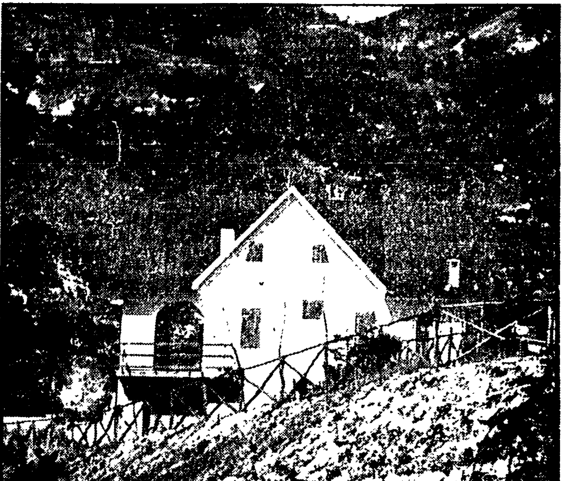
Una costruzione abusiva nel Parco d'Abruzzo
