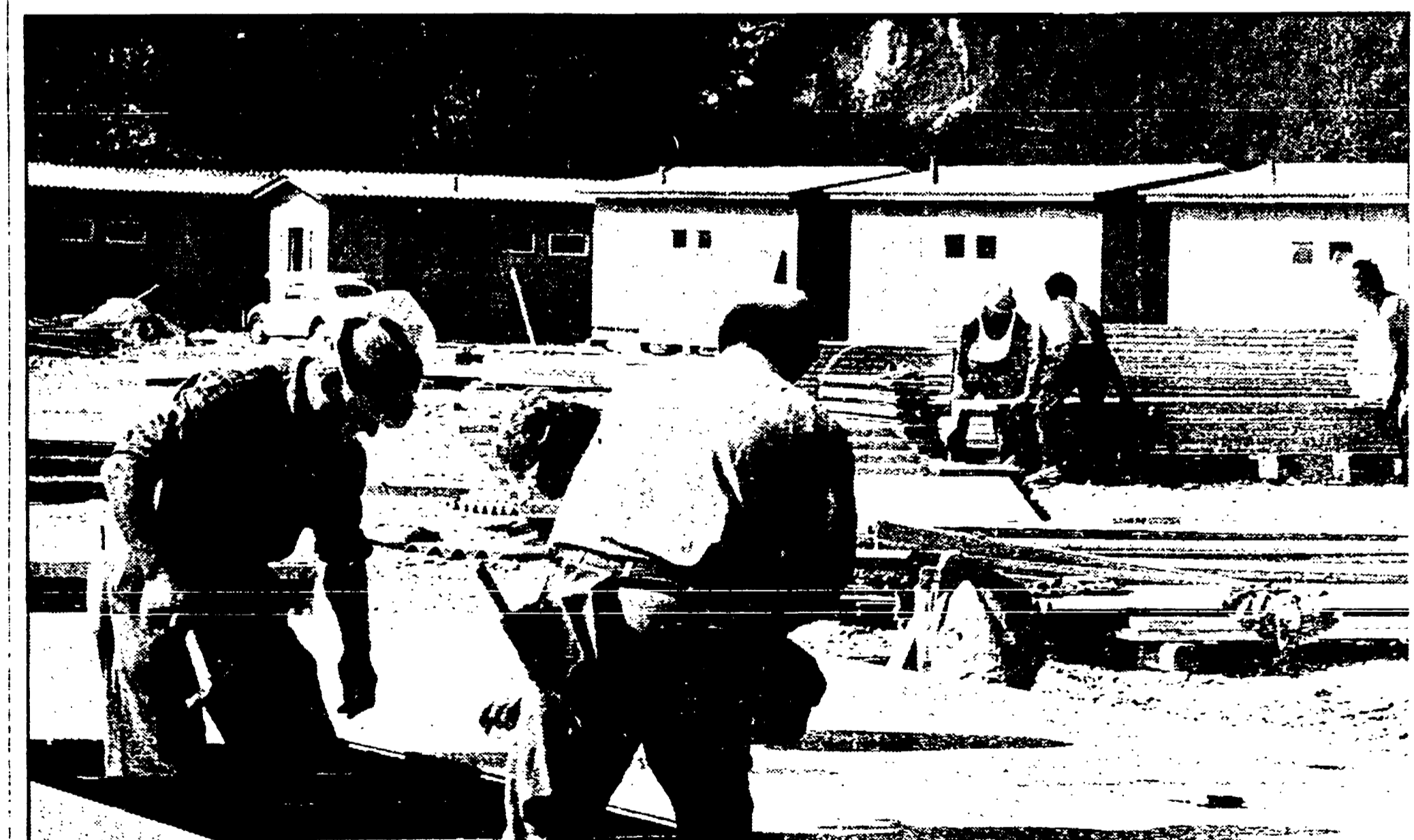
Lavoratori toscani impegnati nell'opera di ricostruzione di un paese friulano colpito dal terremoto
