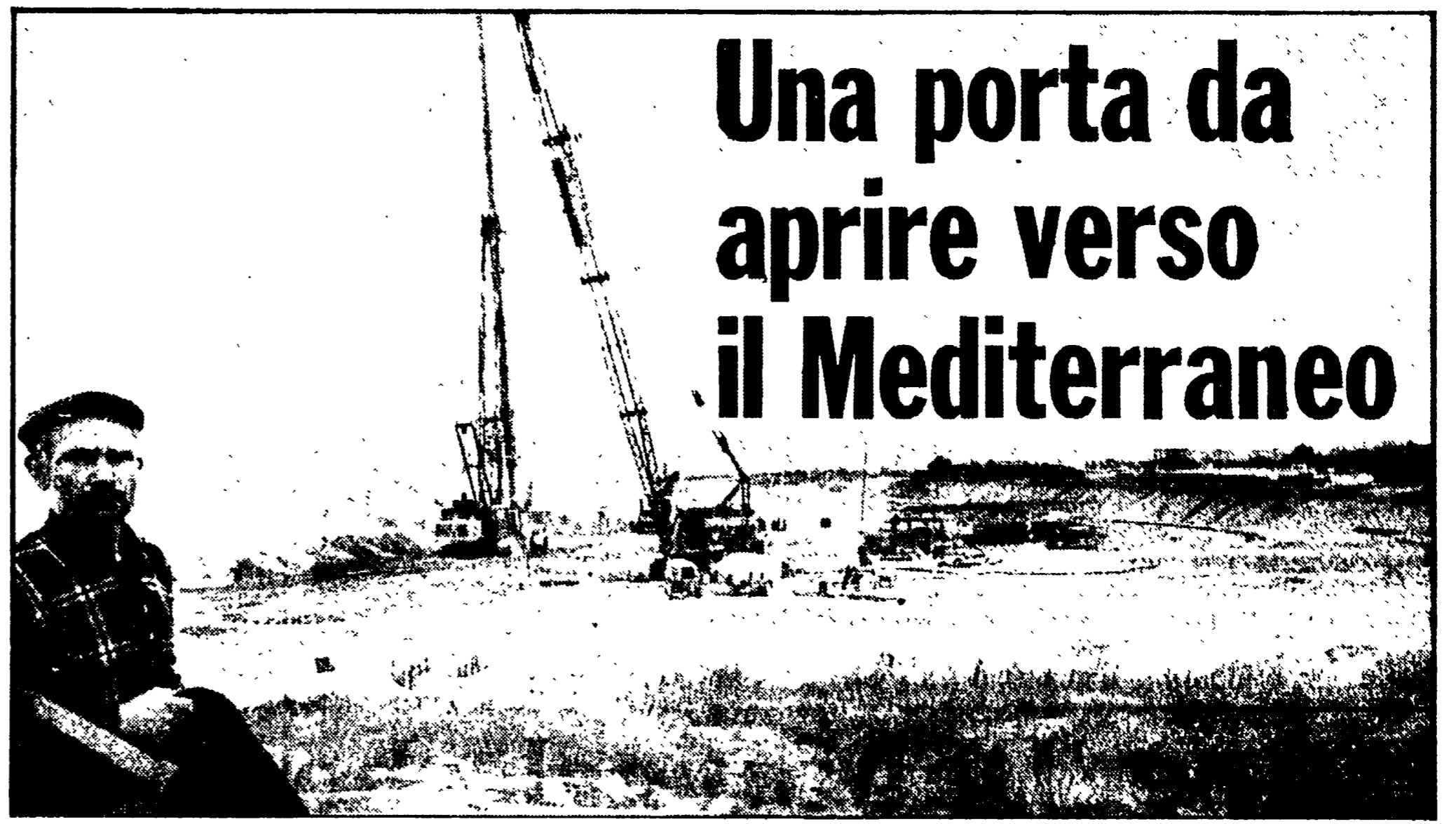
Lavori di sbancamento per il porto di Gioia Tauro
