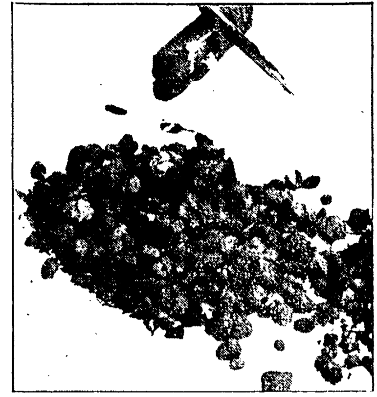
Un particolare dei detriti rimossi da una tubatura intasata
