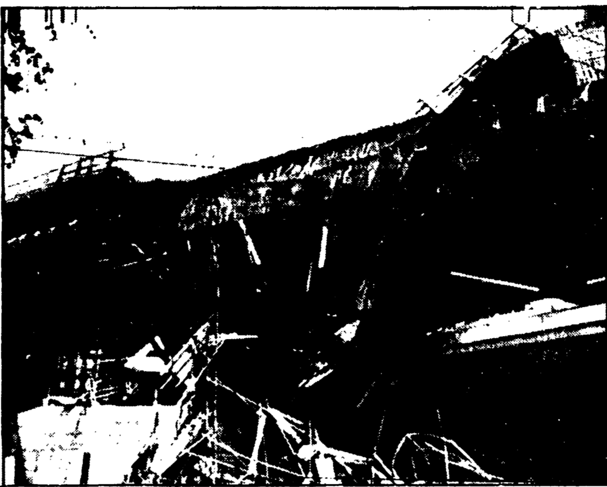
CROLLA IL VIADOTTO Spettacolare incidente in Svizzera, nei pressi di Basilea, dove è crollato il ponte autostradale dello svicolo Basilea-Francoforte-Amburgo. Un operaio addetto ai lavori stradali è rimasto ferito. Nella foto: il ponte crollato
