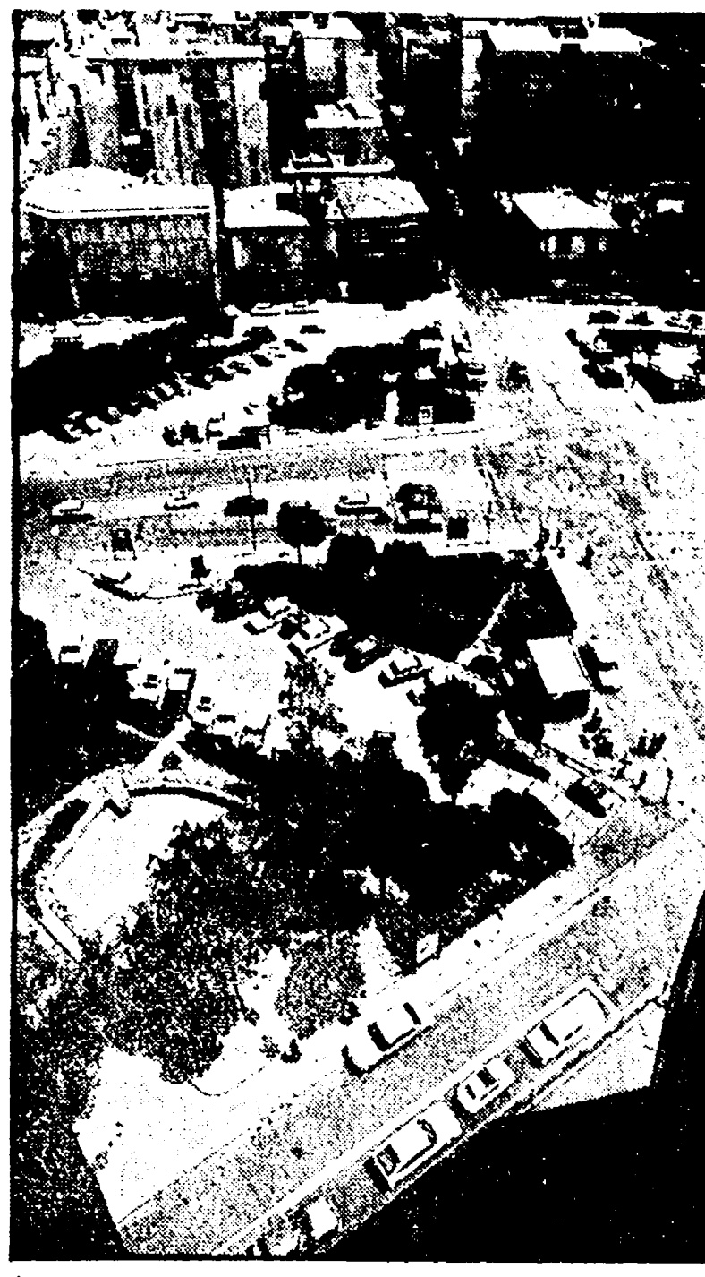
Il quartiere visto dal grattacielo di piazza Matteotti
