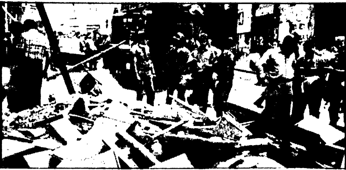
Il tragico crollo nel centro storico napoletano
