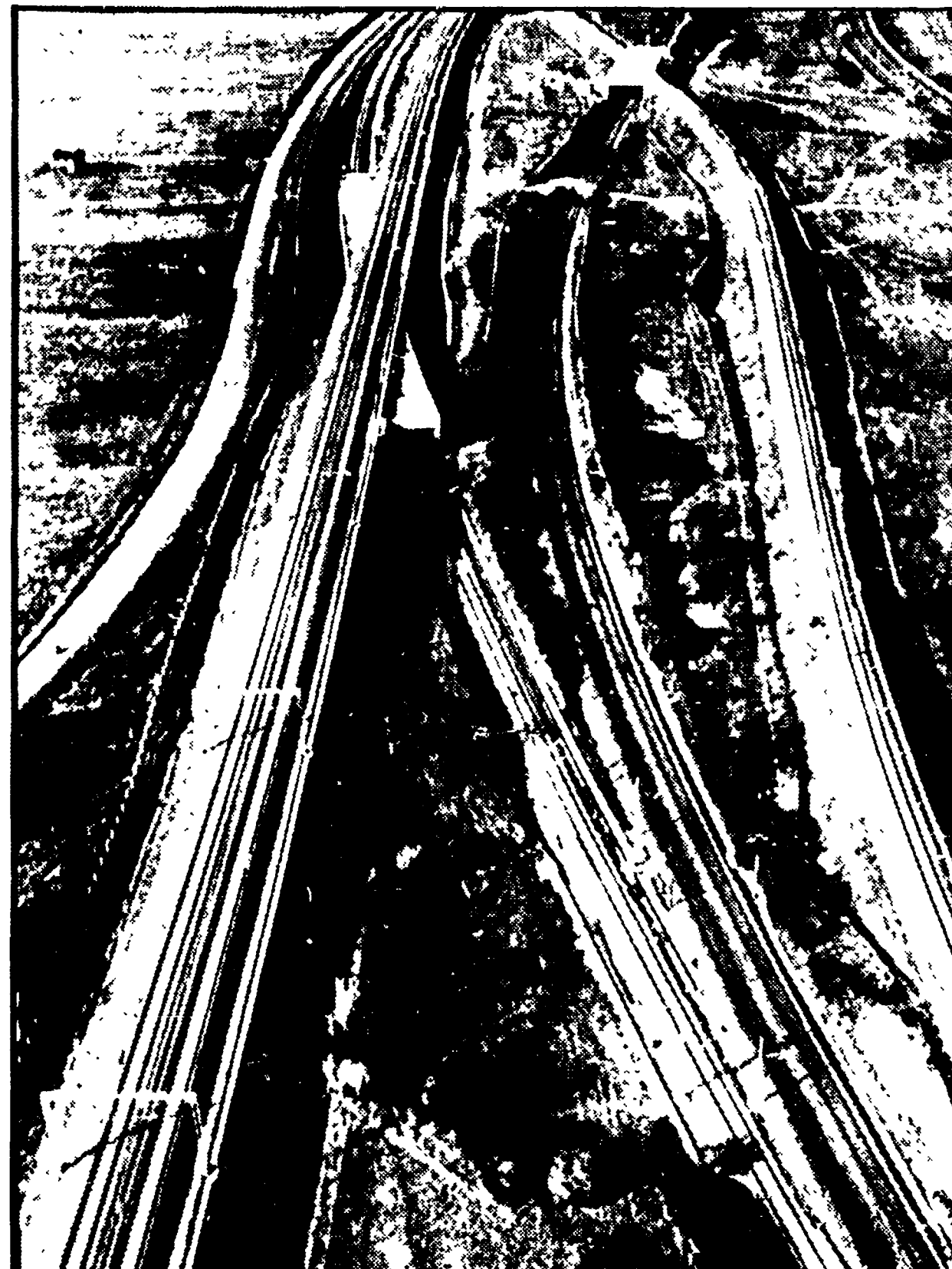
Una veduta aerea della vecchia e nuova linea Firenze-Roma all'incrocio di Orto Nord
