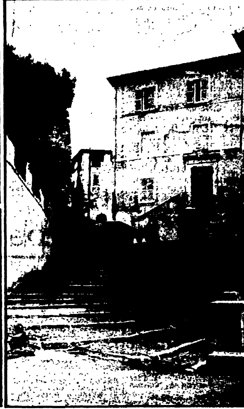
La biblioteca nel municipio di Cori; in basso, la sala delle riunioni; a destra l'ingresso dell'edificio nel cuore del borgo medievale.
