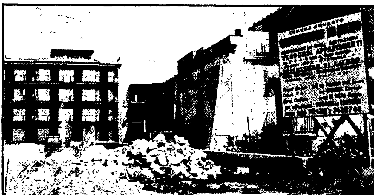
Un cantiere edile a Quarto Flegreo
