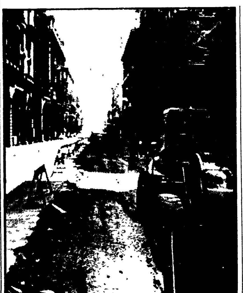
LAVORI D'ESTATE Approfittando dell'estate, il Comune di Genova ha deciso di rifare il manto su una strada tortuosa...
