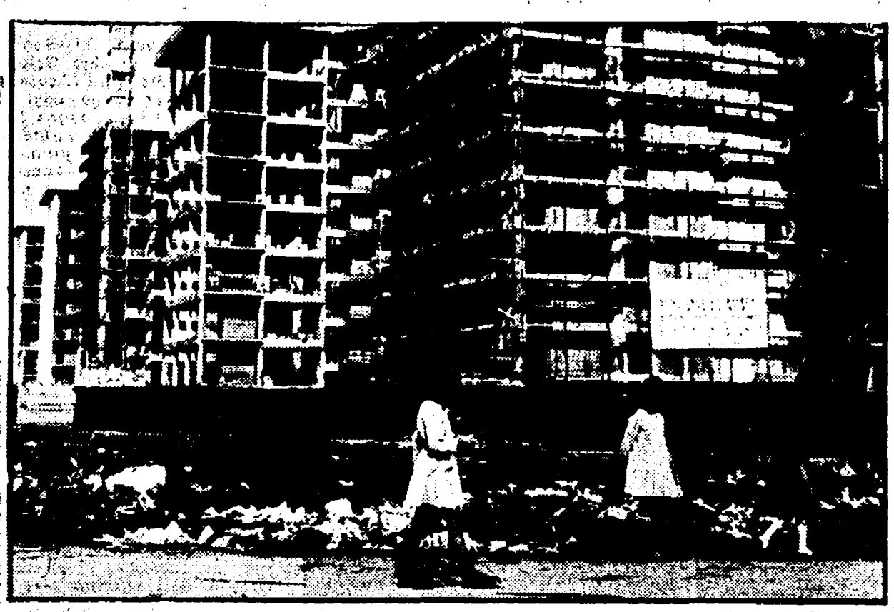
L'inizio dei lavori, nel '71, di 20 appartamenti dell'IACP sull'area 167 di Secondigliano
