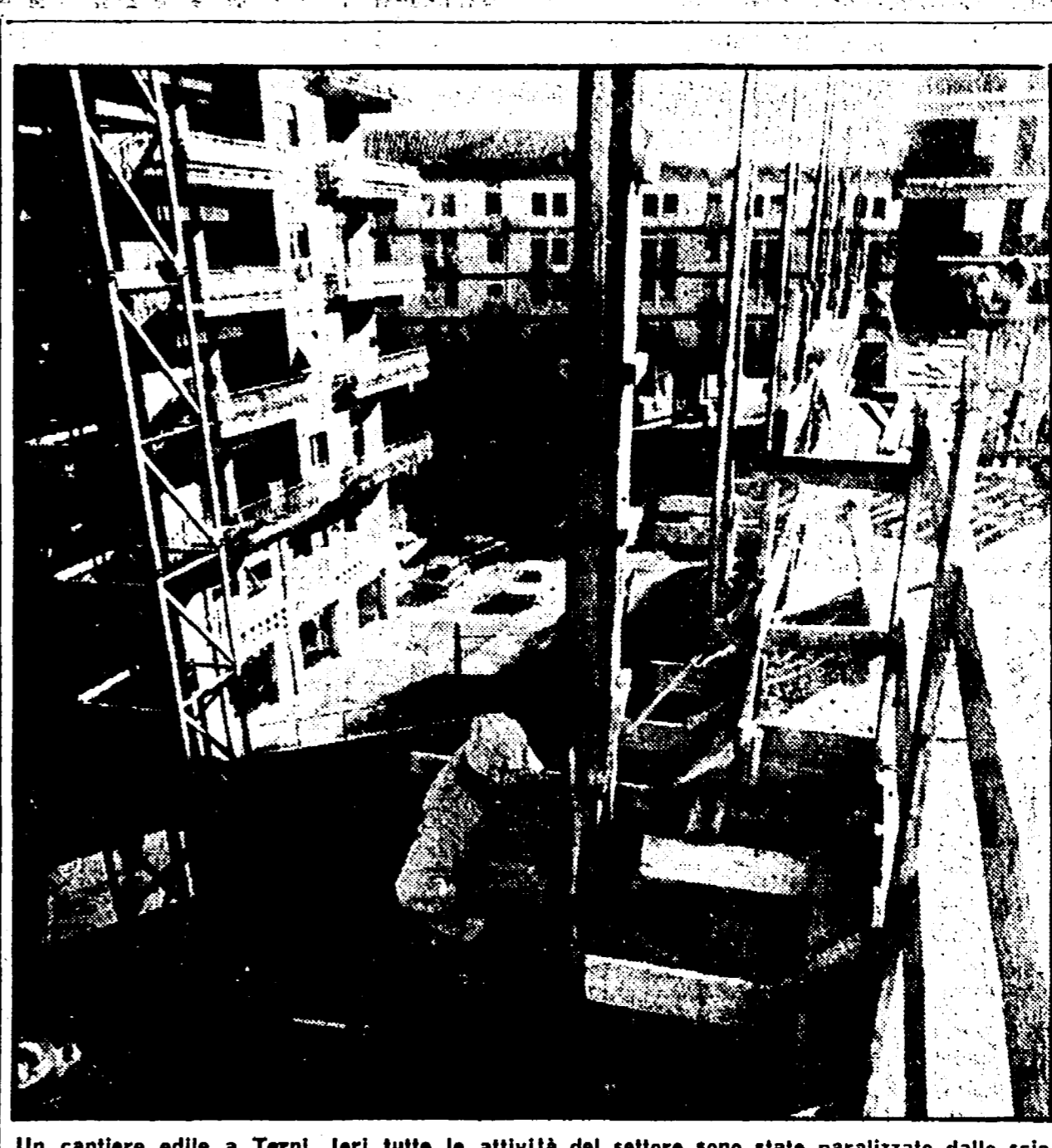
Un cantiere edile a Terni. Ieri tutte le attività del settore sono state paralizzate dallo sciopero dei lavoratori.
