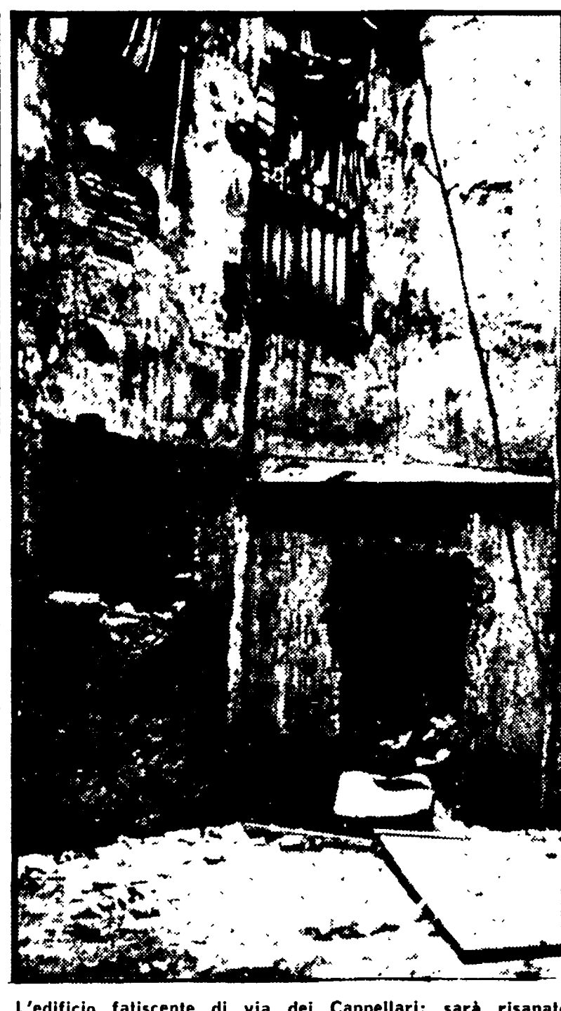
L'edificio fatiscente di via dei Cappellari: sarà risanato
