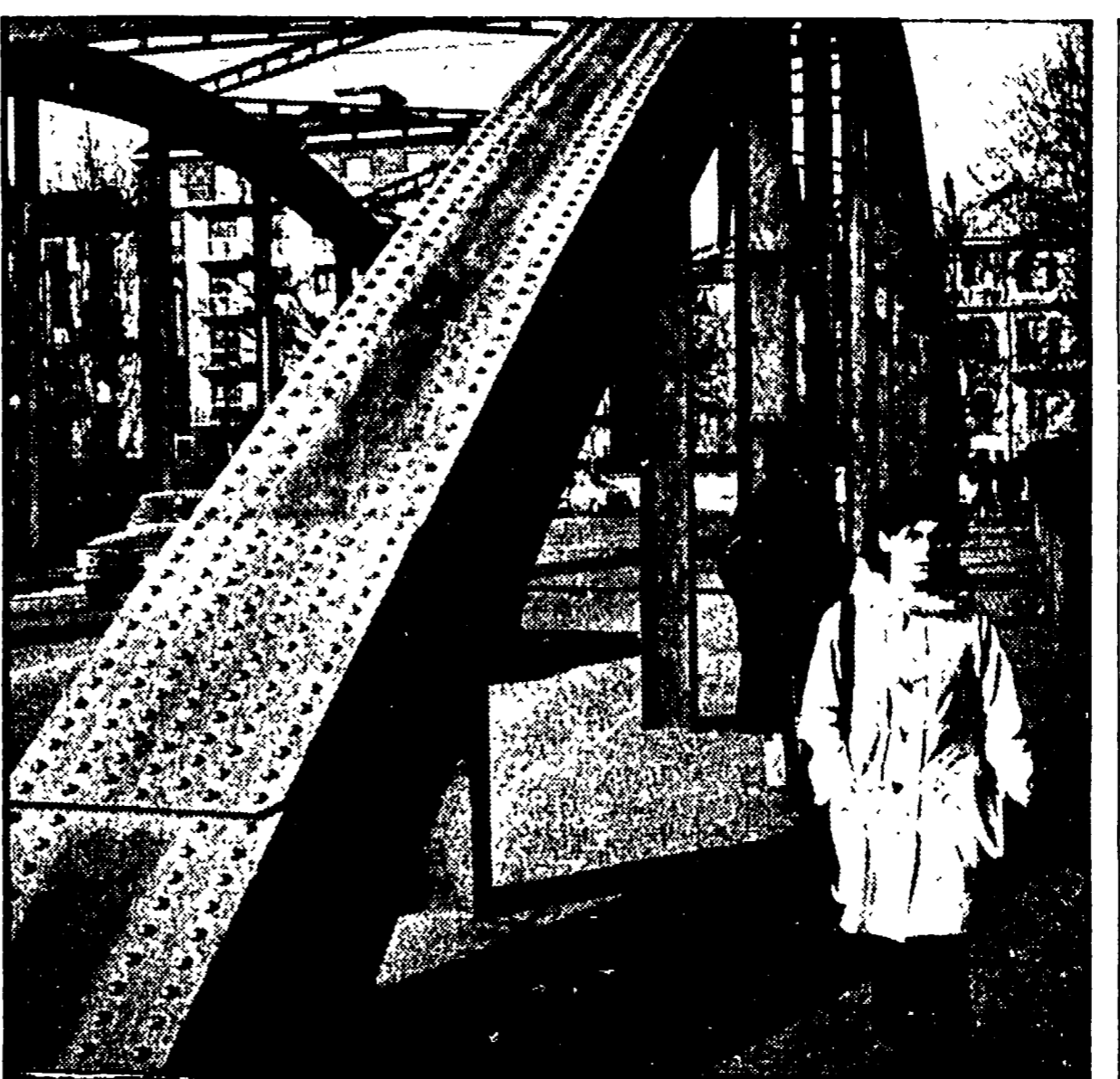
TORINO — Il cavalcavia di Corso Inghilterra
