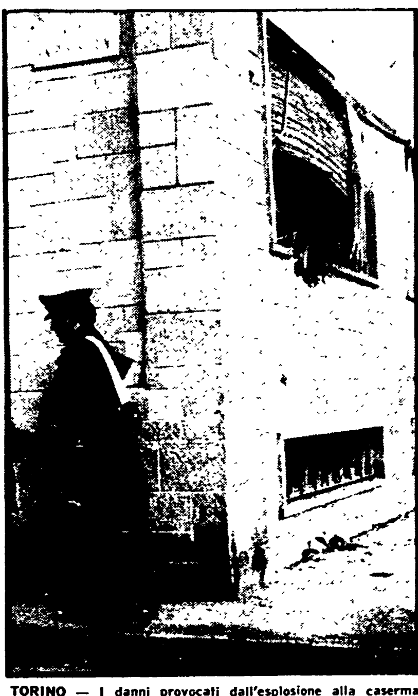
TORINO — I danni provocati dall'esplosione alla caserma dei CC a seguito dell'attentato rivendicato da «Prima linea»
