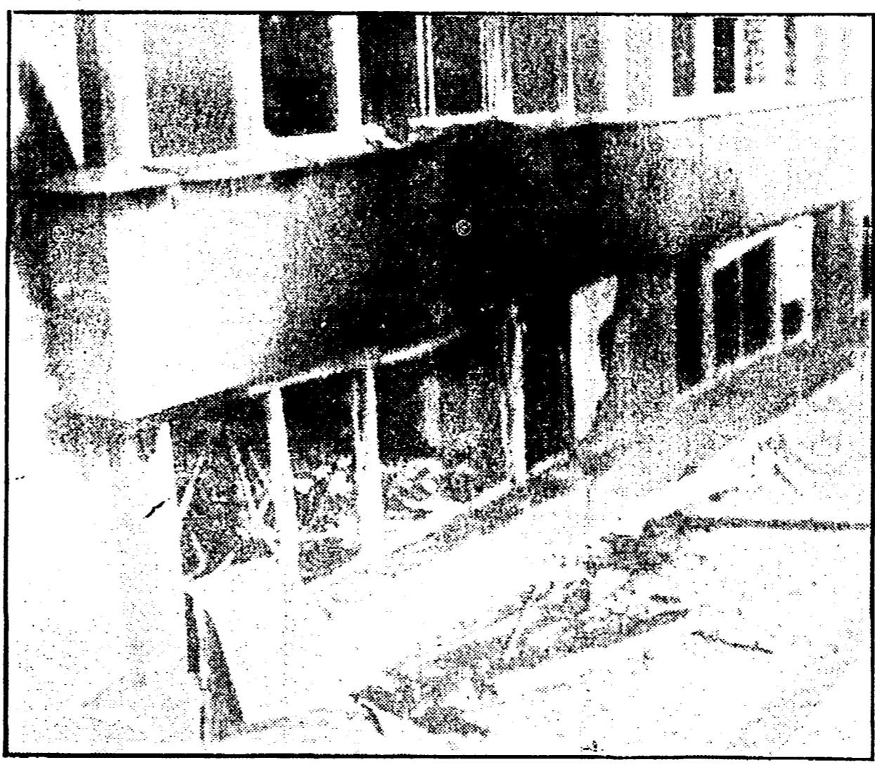
Una vista esterna delle aule del liceo «Rinaldini» semidistrutto dal fuoco
