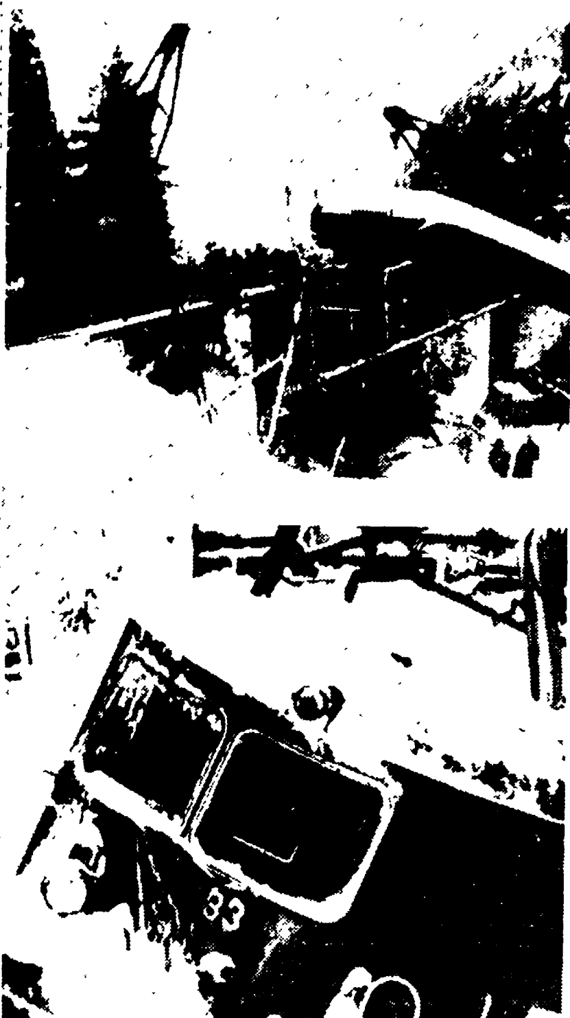
Due drammatiche immagini dell'incidente ferroviario causato da una valanga venerdì scorso sulla linea del Gotardo. Il servizio è già stato ripristinato.
