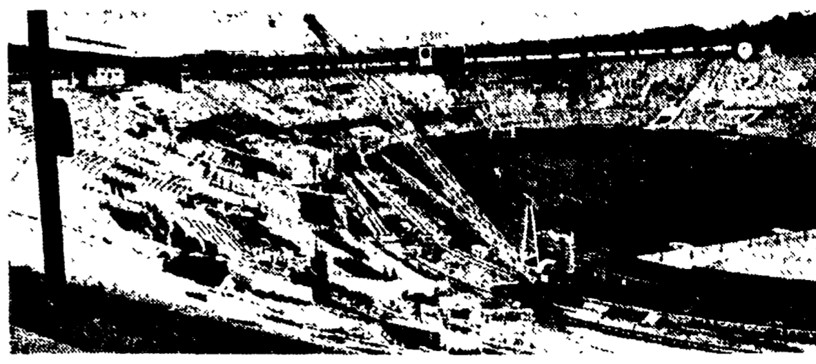
MOSCA - Lavori di restauro allo Stadio «Lenin».
