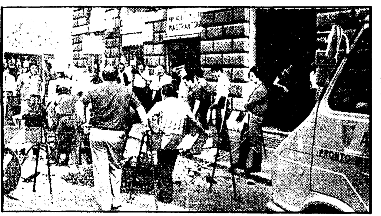
ROMA - Tecnici dell'Acce al lavoro per riparare il guasto
