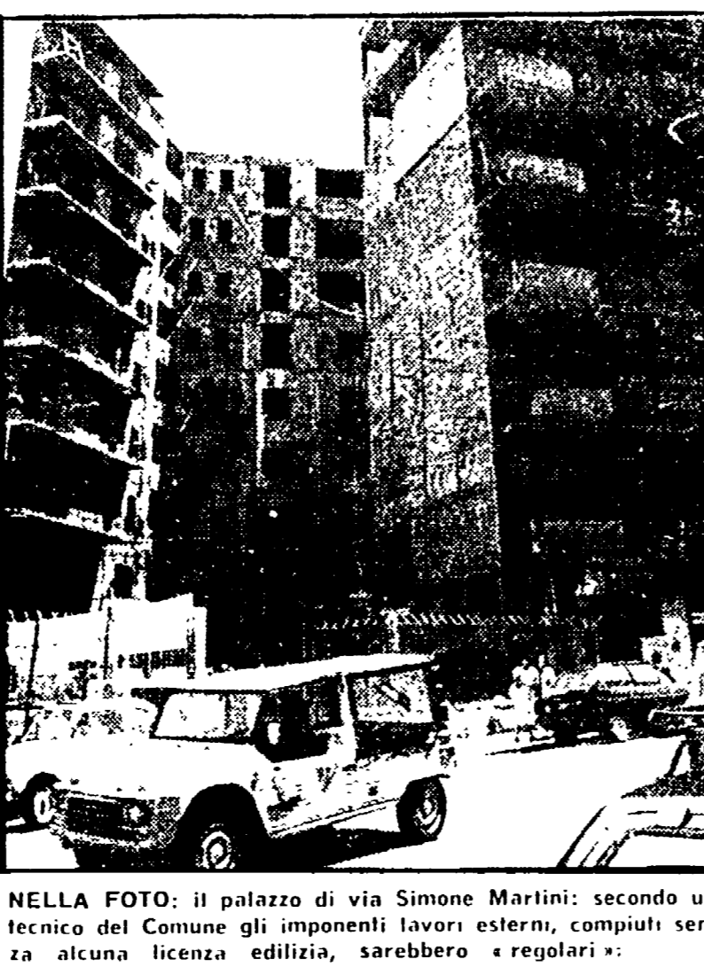
NELLA FOTO: il palazzo di via Simone Martini; secondo un tecnico del Comune gli imponenti lavori esterni, compiuti senza alcuna licenza edilizia, sarebbero «regolari»
