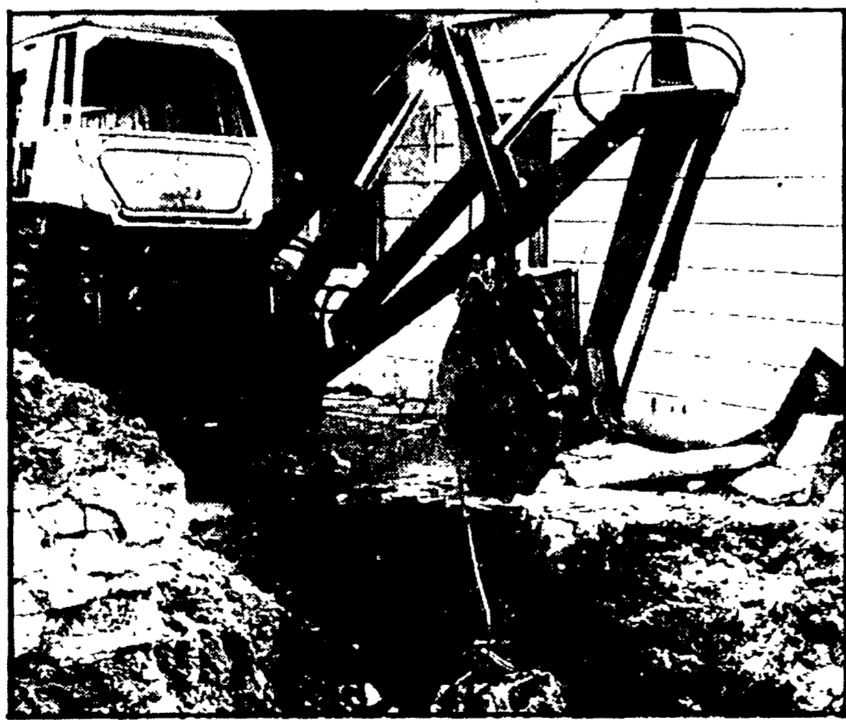
I lavori si sono fermati. Ora Cagliari, oltre a dover subire ulteriori ritardi nella realizzazione della nuova rete fognaria, è anche piena di buche e trincee, scavate per sostituire la vecchia rete
