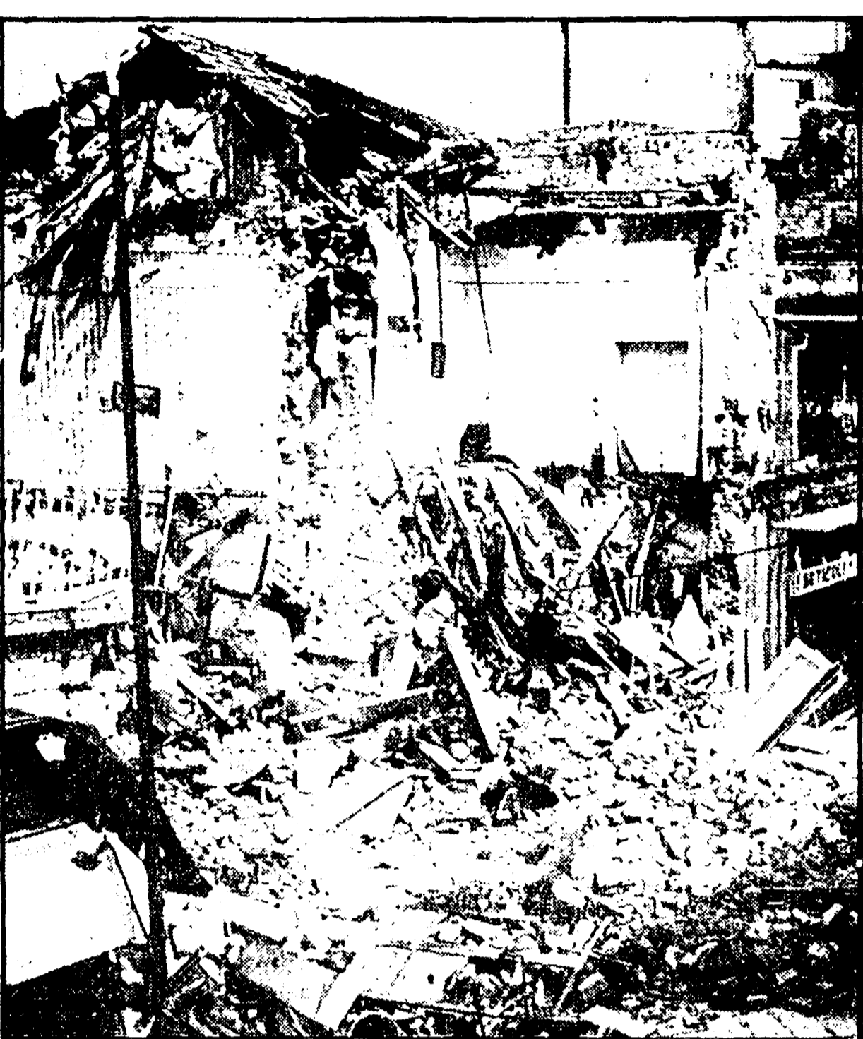
Dopo il crollo dell'edificio di corso Durante a Frattammagiore (nelle foto a sinistra i resti della casa come si presentavano ieri mattina) due nuclei familiari che abitavano nelle adiacenze dell'edificio distrutto sono stati fatti sgomberare. Le due famiglie hanno trovato ospitalità presso alcuni parenti. Alle 11,30 di ieri mattina è crollata anche l'ultima parte dell'edificio che era rimasta ancora in piedi. Vi era un negozio di pasticceria che è andato completamente distrutto. Le forze dell'ordine ed i vigili urbani hanno anche dovuto impedire al titolare dell'esercizio, Carmine Danzica, di entrare nel locale per salvare le suppellettili. L'uomo che ha assistito attonito al crollo del negozio, ha commentato amaramente: « Avevo speso una decina di milioni qualche mese fa per rinnovarlo, adesso non ho più nulla ». Aveva gli occhi rossi per la notte passata accanto alle macerie. In cuor suo — ci ha
