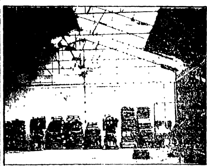
Un capannone scoperciato per il nubifragio
