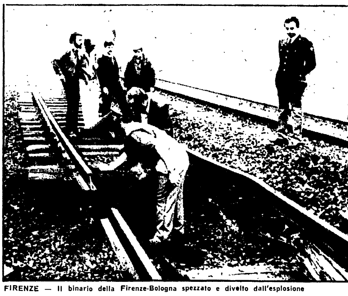
FIRENZE - Il binario della Firenze-Bologna spezzato e divelto dall'esplosione
