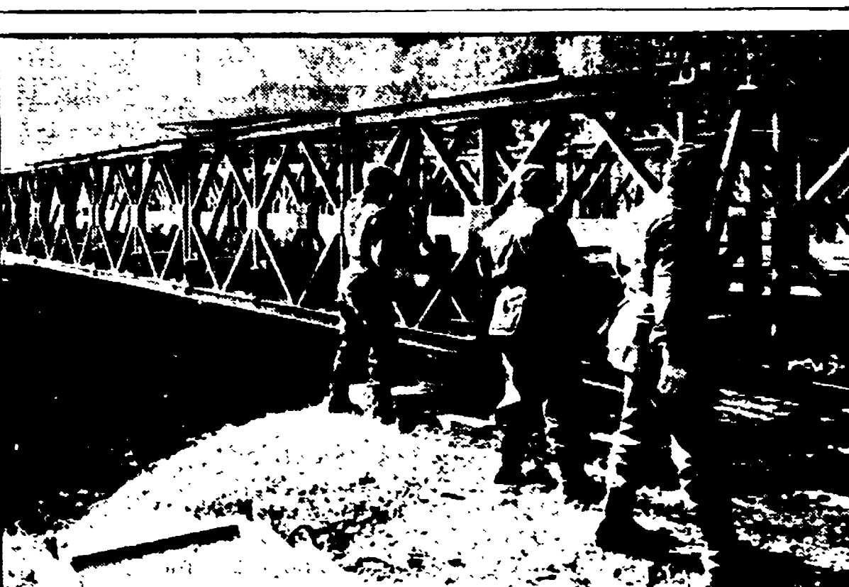
Un ponte in sette ore
