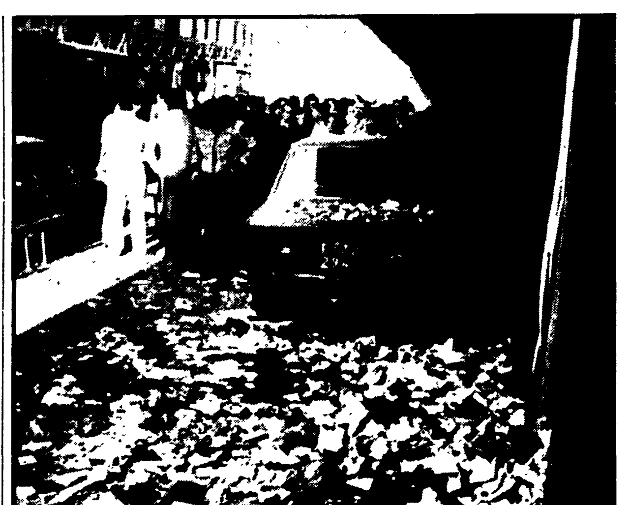
FIRENZE — I danni provocati dall'esplosione dinanzi alla Direzione provinciale del Tesoro
