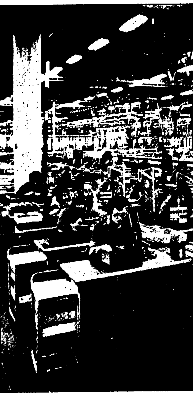
Un reparto della Sit-Siemens di Palermo
