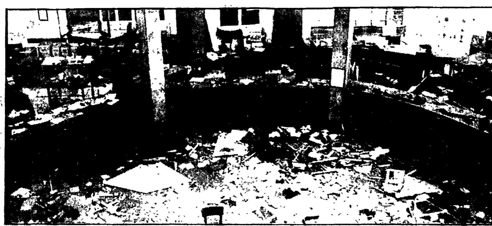
MILANO - La Banca dell'Agricoltura di piazza Fontana dopo la tragica esplosione del dicembre '69
